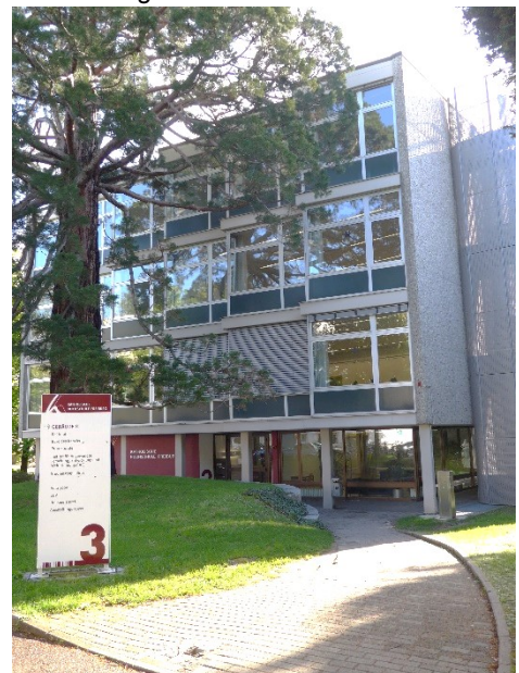
Hauptgebäude, Karlstraße 63 Lehrräume, Rektorat, Verwaltung
